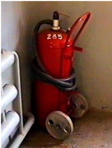
**Порошковые огнетушители (ОП)** предназначены для тушения пожаров твердых, жидких и газообразных веществ (в зависимости от марки используемого огнетушащего порошка), а также электроустановок, находящихся под напряжением до 1 кВ (1000 В). Принцип работы передвижного закачного огнетушителя ОП-50(з) основан на вытеснении огнетушащего порошка (при открытом клапане запорного устройства) сжатым воздухом, находящимся в емкости. Для приведения огнетушителя в действие необходимо выполнить следующее:
